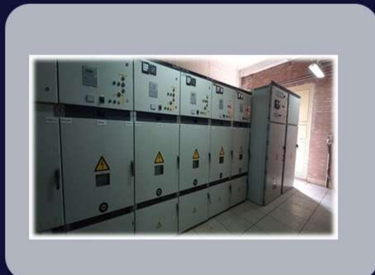
تعمیرات پیشگیرانه و سرویس نگهداری تابلو برق های فشار متوسط فولادسازی
